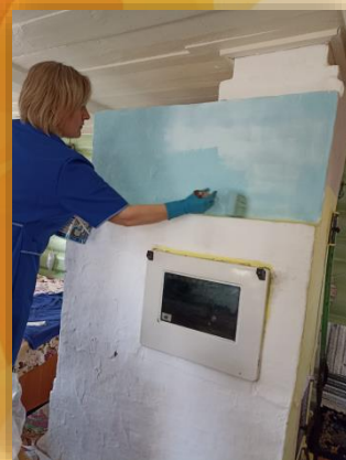
Побелка, покраска стен, печей
